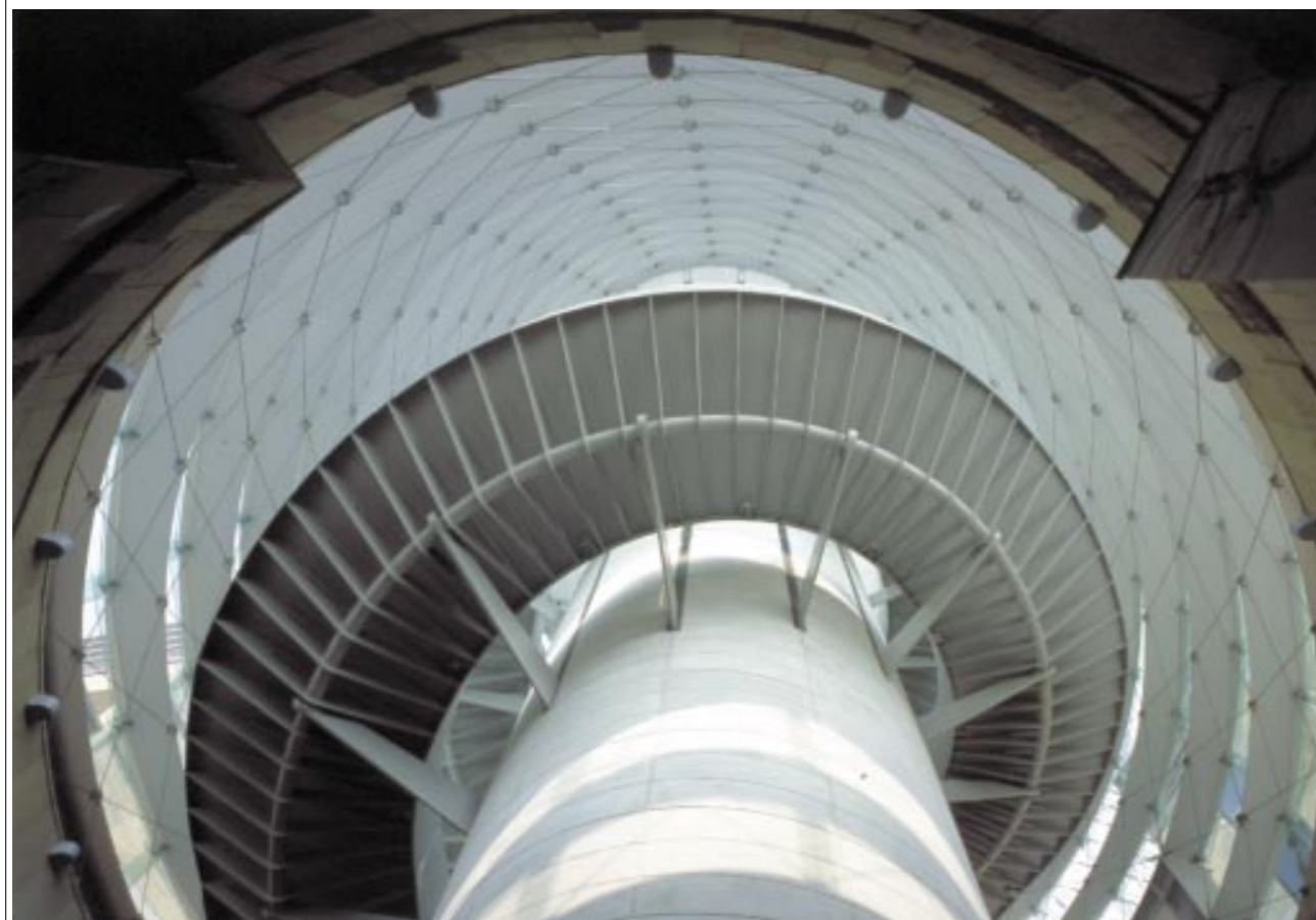
写真4 螺旋階段を見上げる
