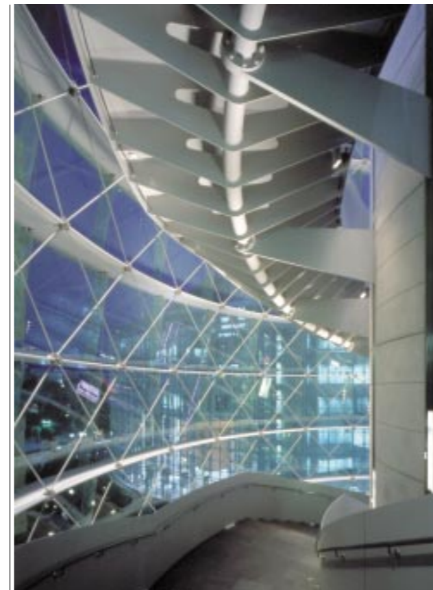
写真5 内観 螺旋階段キールパイプと三角プレート
